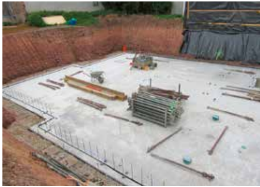
Fertigstellung der Bodenplatte
