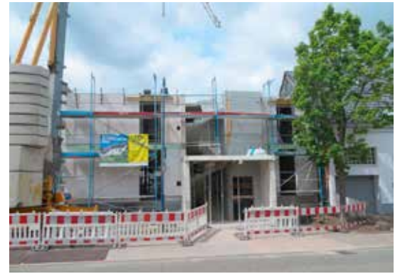
Fertigstellung des 1. Obergeschosses
