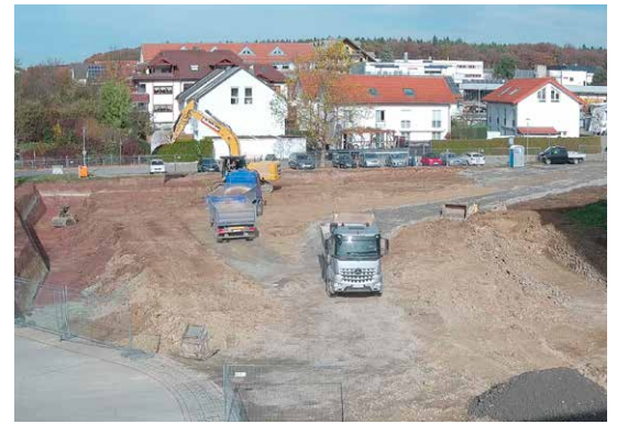
Vorbereitung des Baufeldes
