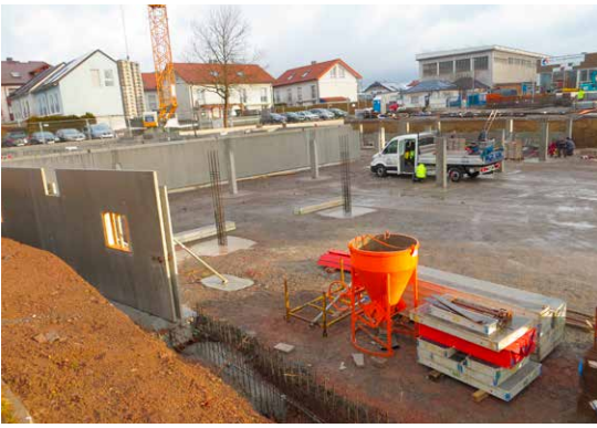
Errichtung des Kellergeschosses
