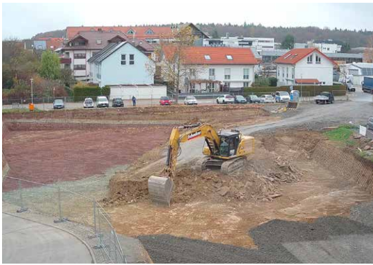
Aushub der Baugrube
